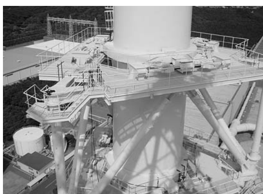
写真10 補強リング、オイルダンパー取付状況
