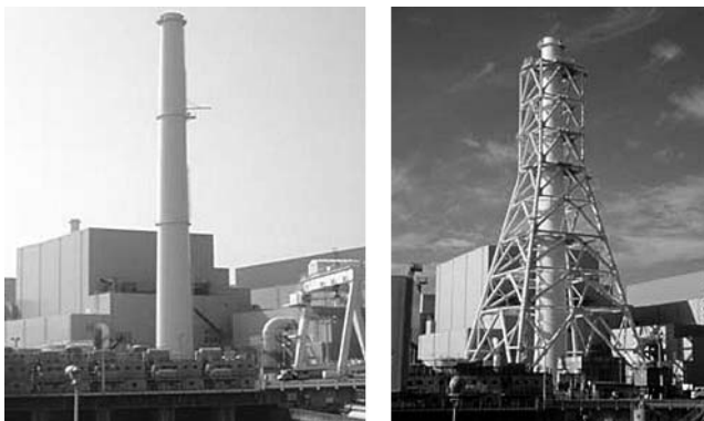
写真1 4号機排気筒の全景(工事前と工事終了後)
