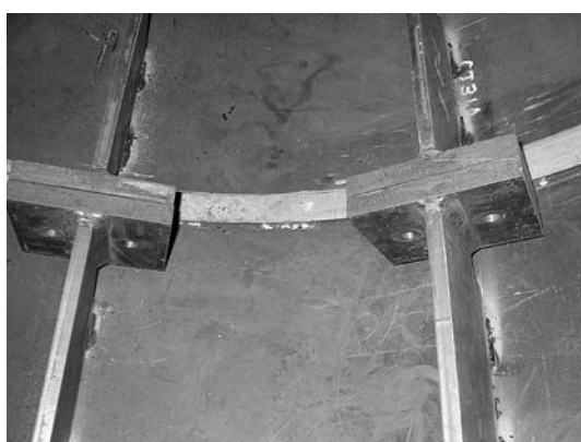
写真3 柱継手部(内面)
